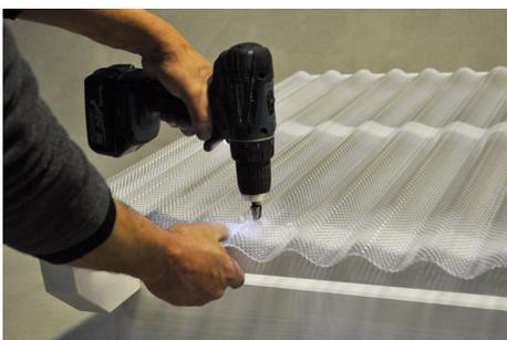
Zum Bohren der Befestigungslöcher muss ein geeigneter Kegel- oder Stufenbohrer verwendet werden. Unbedingt auf glatte Bohrränder achten. Die Bohrlöcher sind mindestens 4 mm größer als der Schraubenschaftdurchmesser zu dimensionieren. Bei der späteren Verschraubung dürfen sich Schraube und Bohrloch nicht berühren, die auftretenden Längenänderungen durch Temperatur- und Feuchtigkeitsschwankungen müssen mit berücksichtigt werden.
