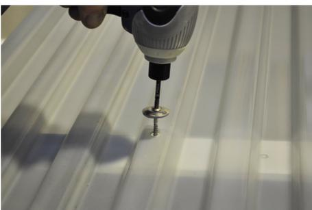
Wellplatten aus PVC und Polycarbonat sind mittig durch das Bohrloch mit geeigneten Schrauben zu befestigen. Hierbei dürfen die Schrauben nicht zu fest angezogen werden. Schraube und Bohrloch dürfen sich nicht berühren.
