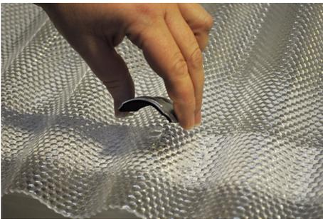
Für die Befestigung der Platten mit der Unterkonstruktion sollten Kalotten verwendet werden. Die Kalotte ist zunächst passend (mittig) über das Bohrloch zu legen.
