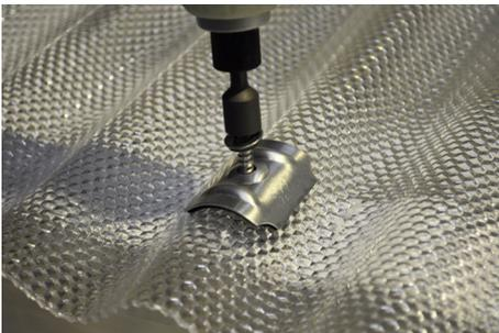
Die Platten sind mittig durch das Bohrloch mit geeigneten Schrauben zu befestigen. Hierbei dürfen die Schrauben nicht zu fest angezogen werden. Schraube und Bohrloch dürfen sich nicht berühren.
