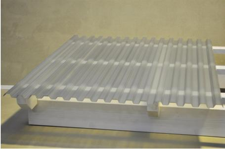
Platten mit der gekennzeichneten Seite nach außen auf die Unterkonstruktion legen. Die Plattenoberseite ist stets die Bewitterungsseite. Strukturierte Wellplatten sind mit der Strukturseite nach innen zu verlegen. Wellplatten aus PC oder PVC sind zwingend mit der gekennzeichneten UV-Schutzseite nach außen zu verlegen.
