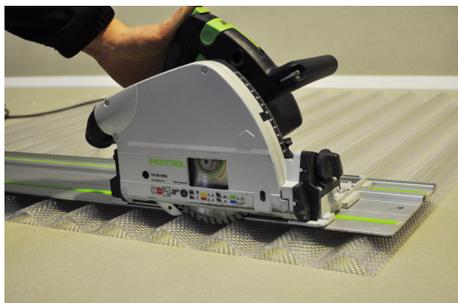
Wellplatten können bauseitig mit einer hochoffenen Kreissäge geschnitten werden. Hartmetallbestückte Vielzahnblätter verwenden. Es ist darauf zu achten, dass die Platten beim Zuschneiden fest aufliegen. Wellplatten sollten gegen "Flattern" eingespannt werden. Beim Schneiden der Platten ist ein Seitenanschlag zu verwenden, um das Verkanten der Säge und dadurch Unfallgefahren sowie mögliches Einreißen der Wellplatten zu vermeiden.
