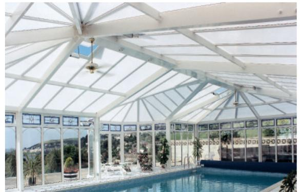
Hitzereduzierende Stegplatten aus Polycarbonat
